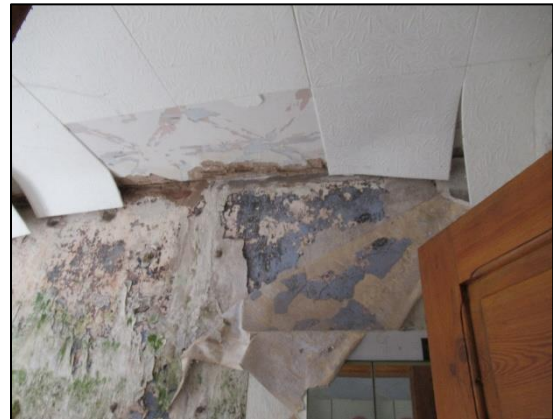
Feuchtesch., Putz-/Farbabplatzungen
