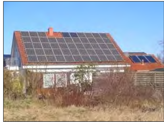
Grundstücksblick von Süden
