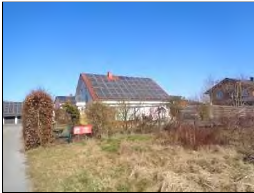
Grundstücksblick von Süden
