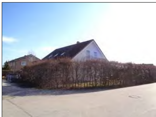
Grundstücksblick von T- Kreuzung
