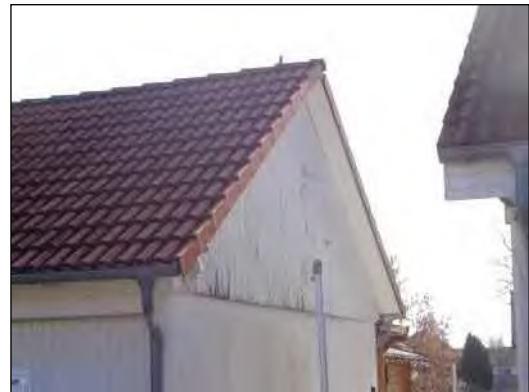
Detailansicht Giebelfassade der Garage
