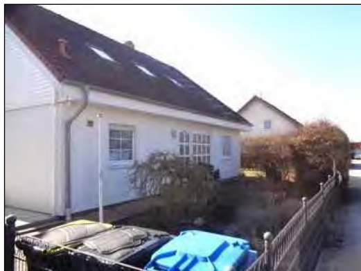
Straßenseitige Nordfassade und Vorgarten
