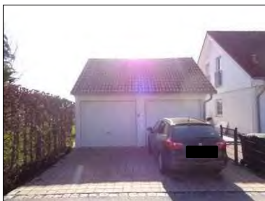
Doppelgarage, straßenseitige Nordfassade
