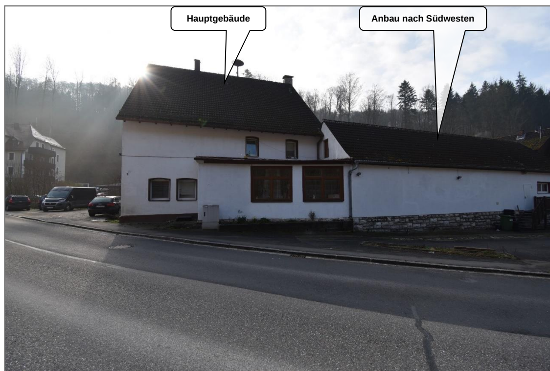
Blick über die Kreisstraße nach Südosten auf das Bewertungsgrundstück (nördlicher Grundstücksteil)
