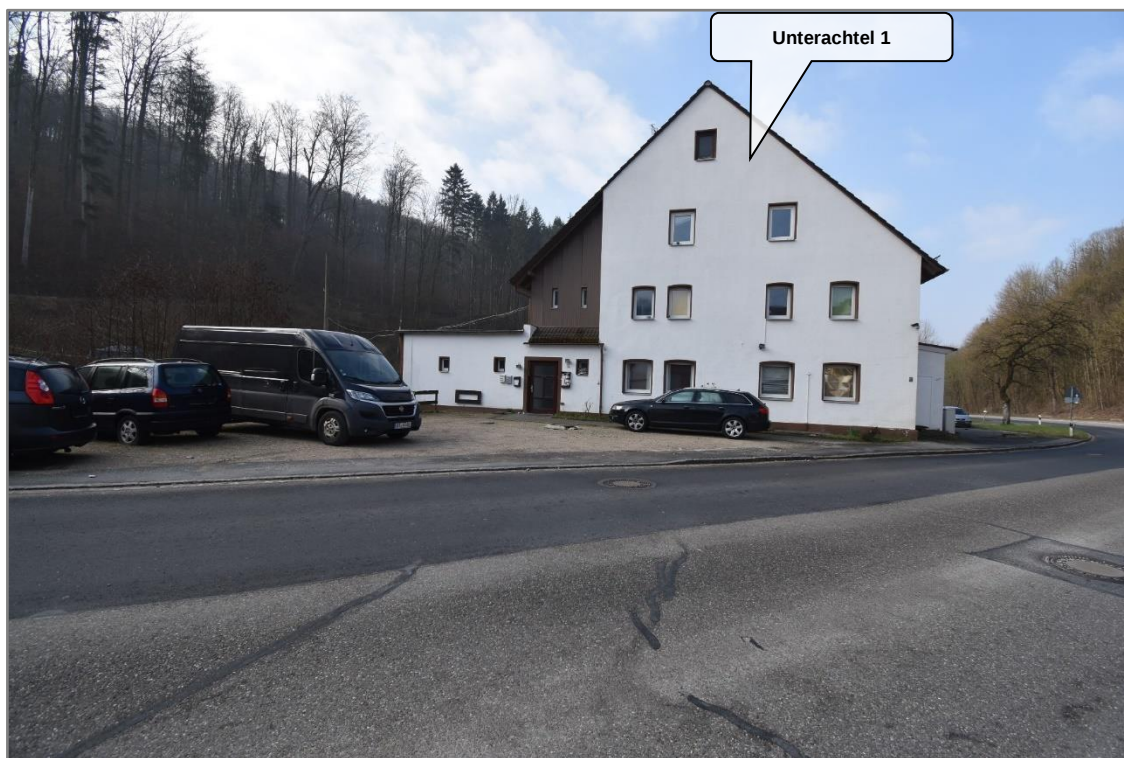
Blick über die Kreisstraße nach Südwesten auf das Bewertungsgrundstück (nördlicher Grundstücksteil)
