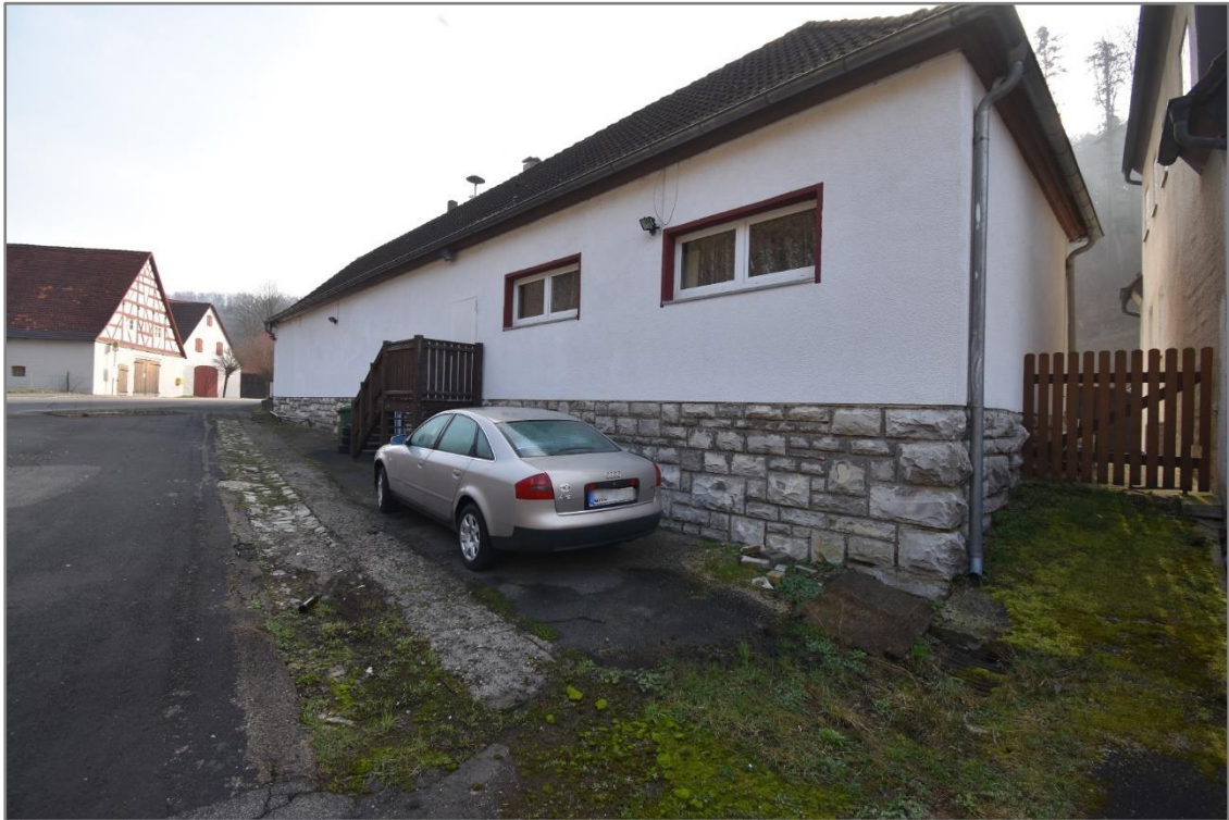
Nördlicher Grundstücksteil, Blick nach Osten auf den Anbau nach Südwesten
