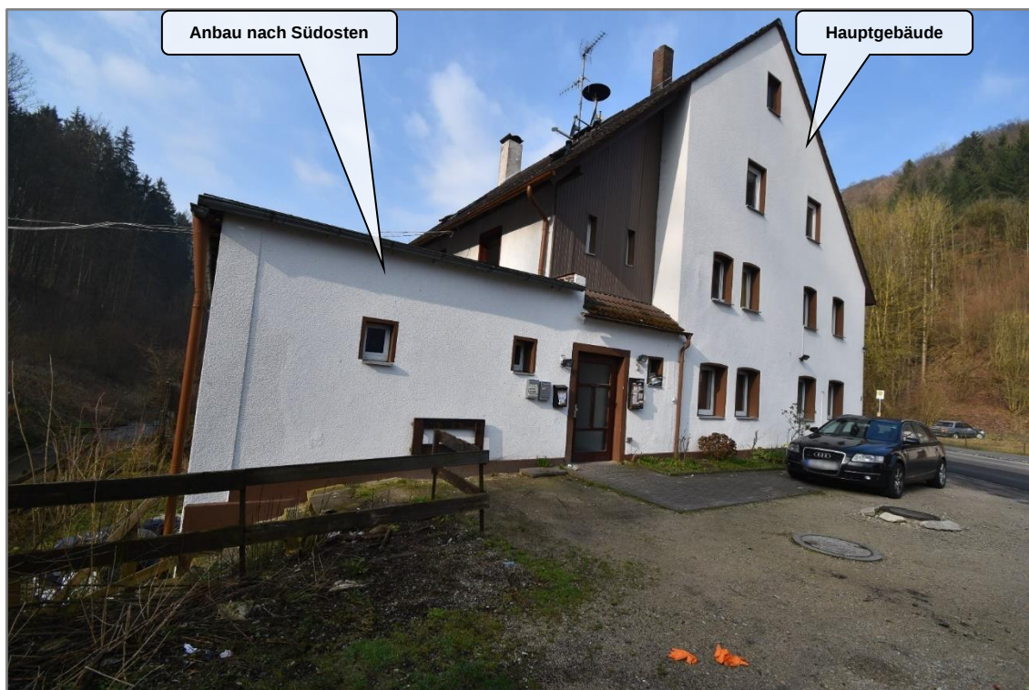
Nördlicher Grundstücksteil, Blick von der vorderen Freifläche aus nach Südwesten
