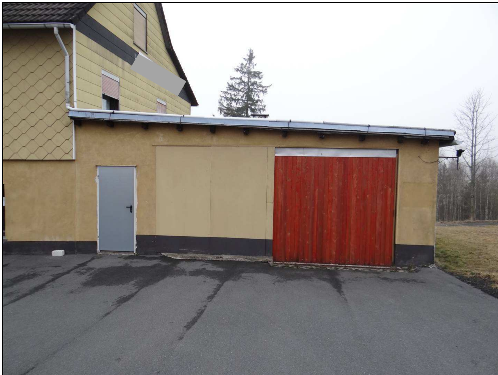
Bild 2: Süd-Ansicht (östlicher Gebäudeteil)
