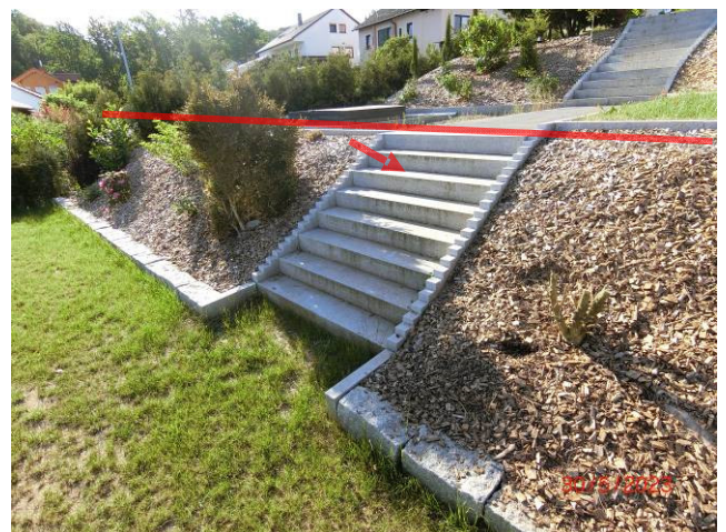
Treppenanlage und Hangsicherung an der südlichen Grundstücksgrenze
