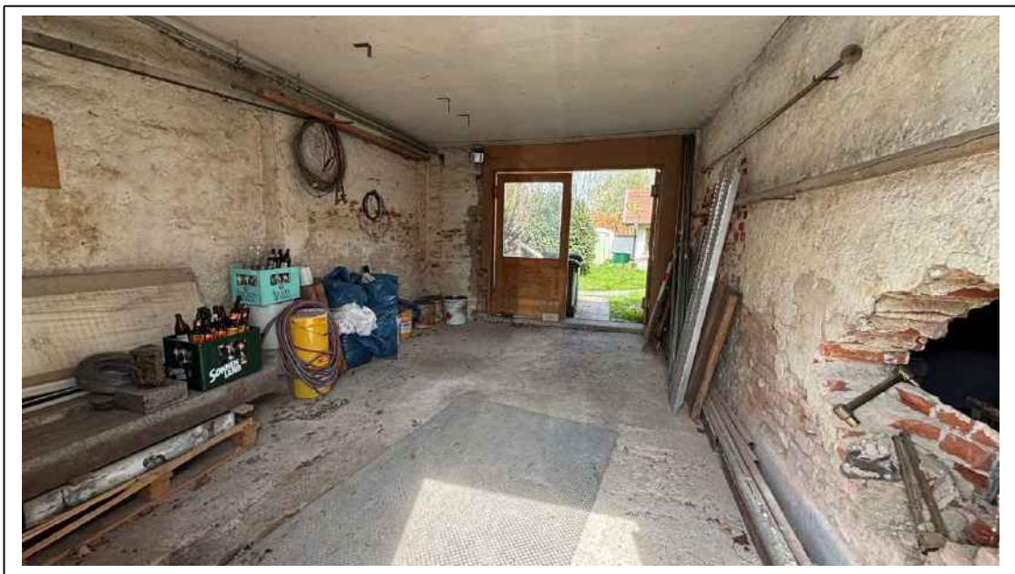
Foto 6: Blick in das Garagengebäude
