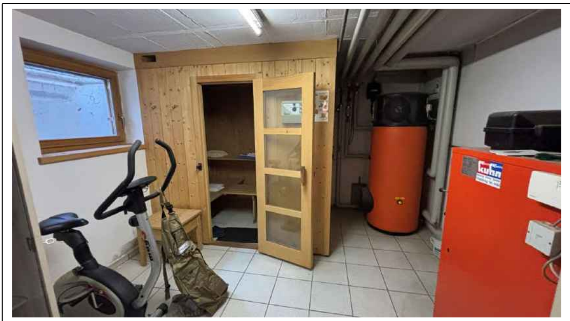
Foto 32: ursprünglicher Heizungskeller mit Sauna / Keller-Anbau
