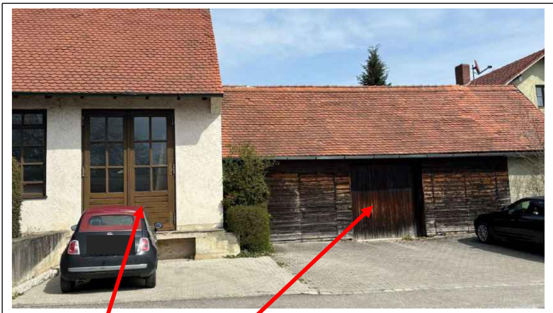
Foto 4: Überbau und Garagengebäude - Ansicht von Süden
