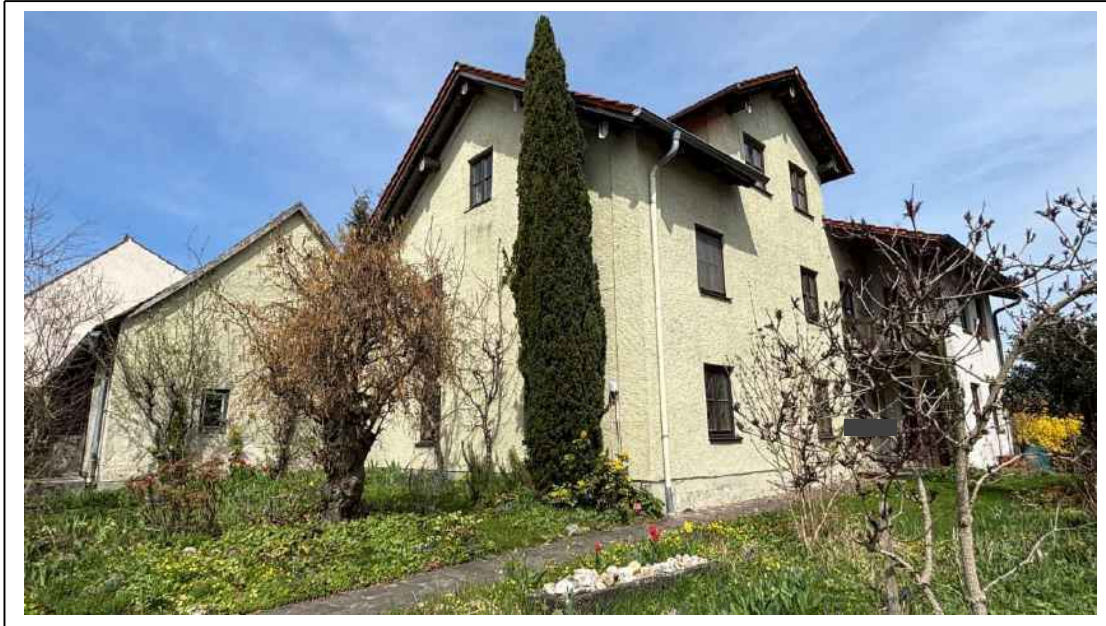
Foto 1: Ansicht von Südosten
