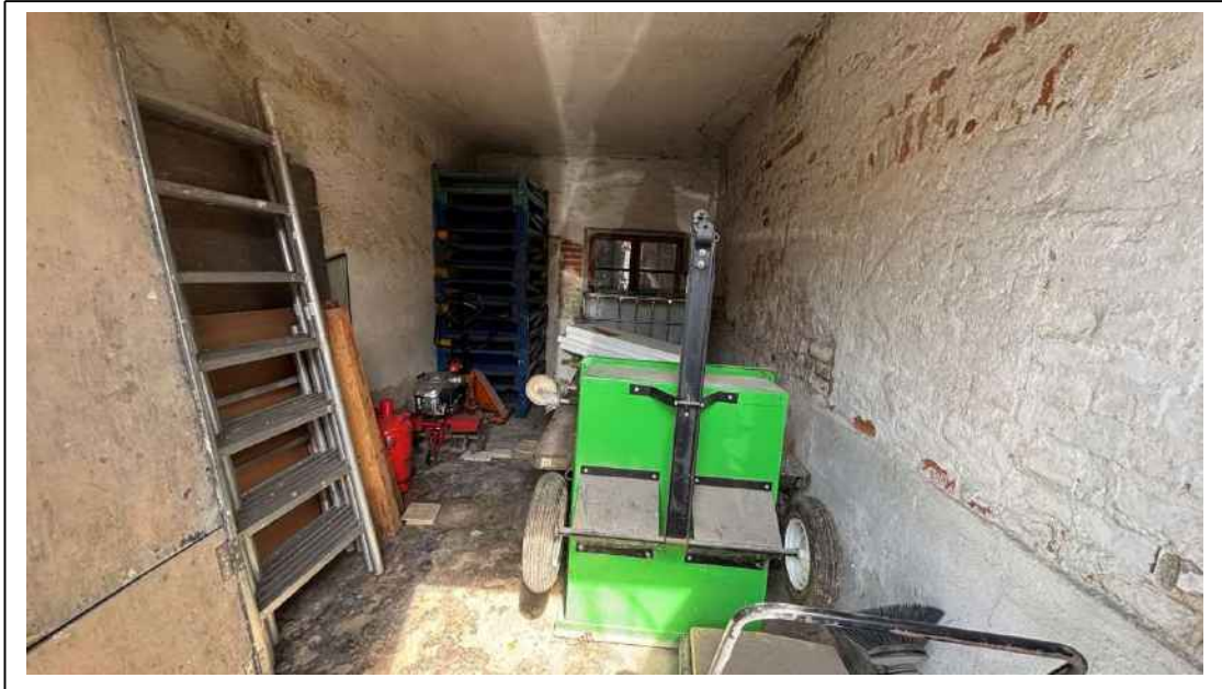
Foto 5: Blick in das Garagengebäude
