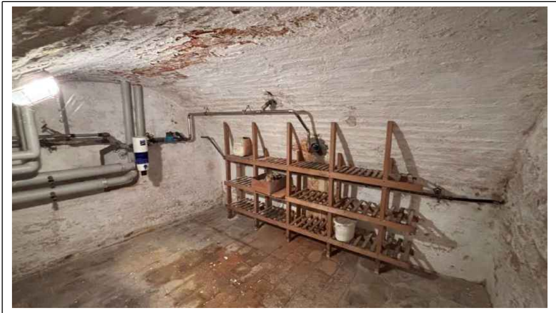
Foto 33: alter Gewölbekeller im Altbau
