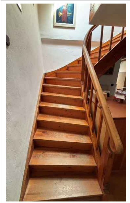
Foto 26: im Altbau: Treppe zum DG
