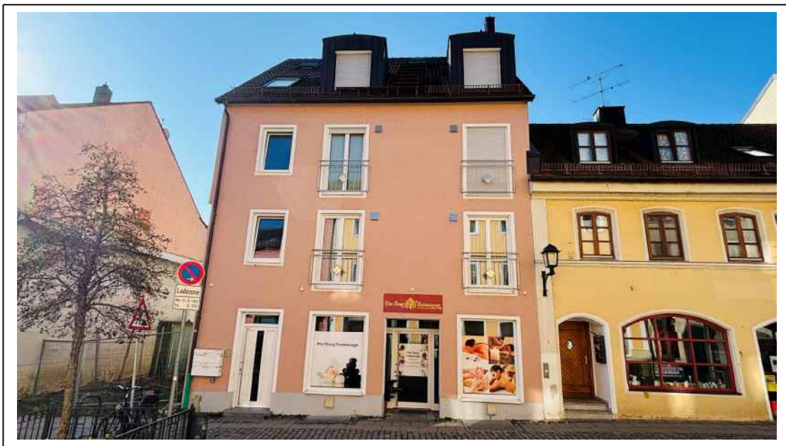
Foto 2: Ansicht von Norden
