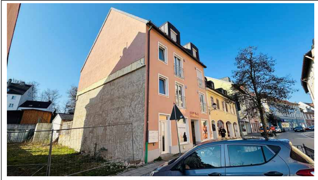
Foto 1: Ansicht von Nordosten
