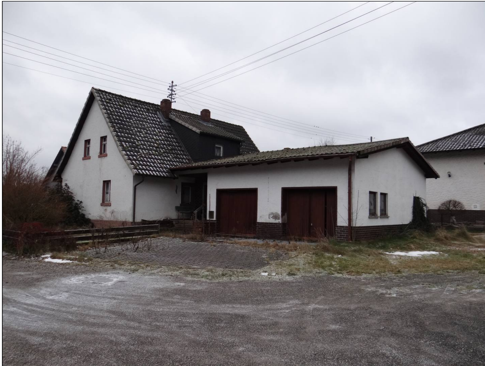
Bild 1: Blick auf das Wohngebäude mit Anbau von Nord-Osten
