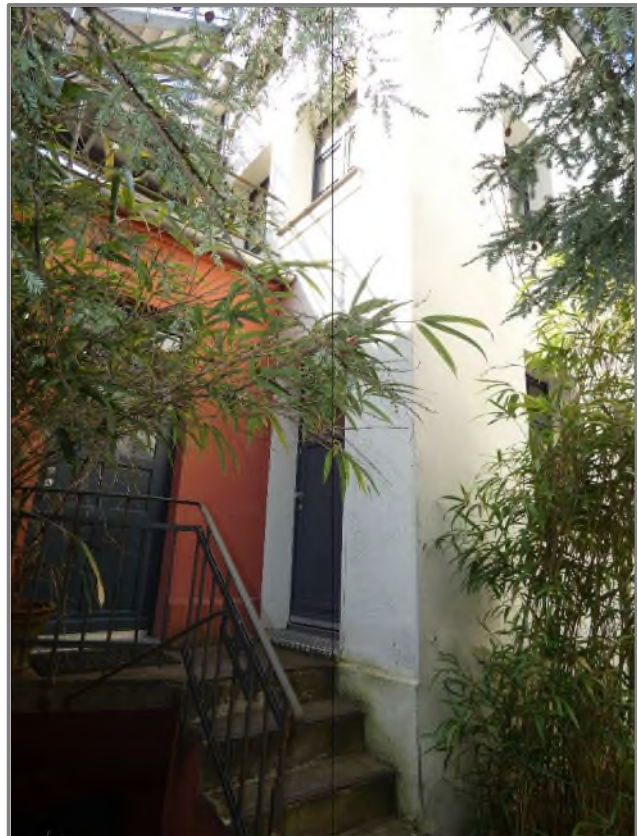
Gebäude 3 - Ansicht von Nordosten
