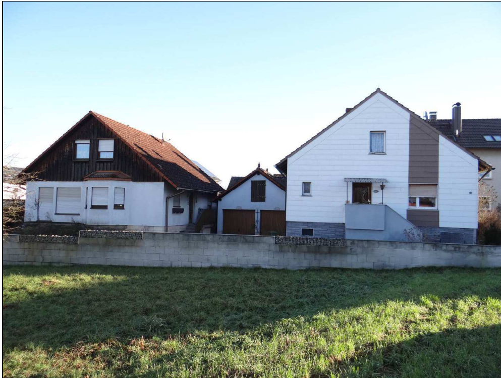
Bild 1: Blick auf Hs.Nr. 10a (links) und Hs.Nr. 10 (rechts) von Westen
