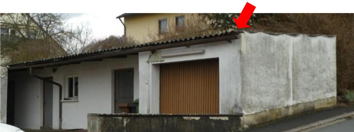
**Detail Nebengebäude ó Dach mit Asbestzementwellplatten.**
