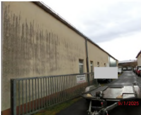
und Blick entlang der Gebäudefassade W in Richtung S ...
