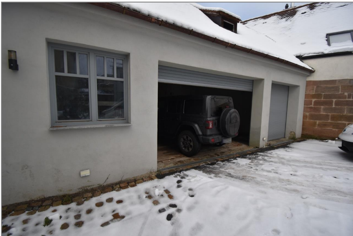
Blick vom Hof aus auf das Garagengebäude mit zwei Rolltoren
