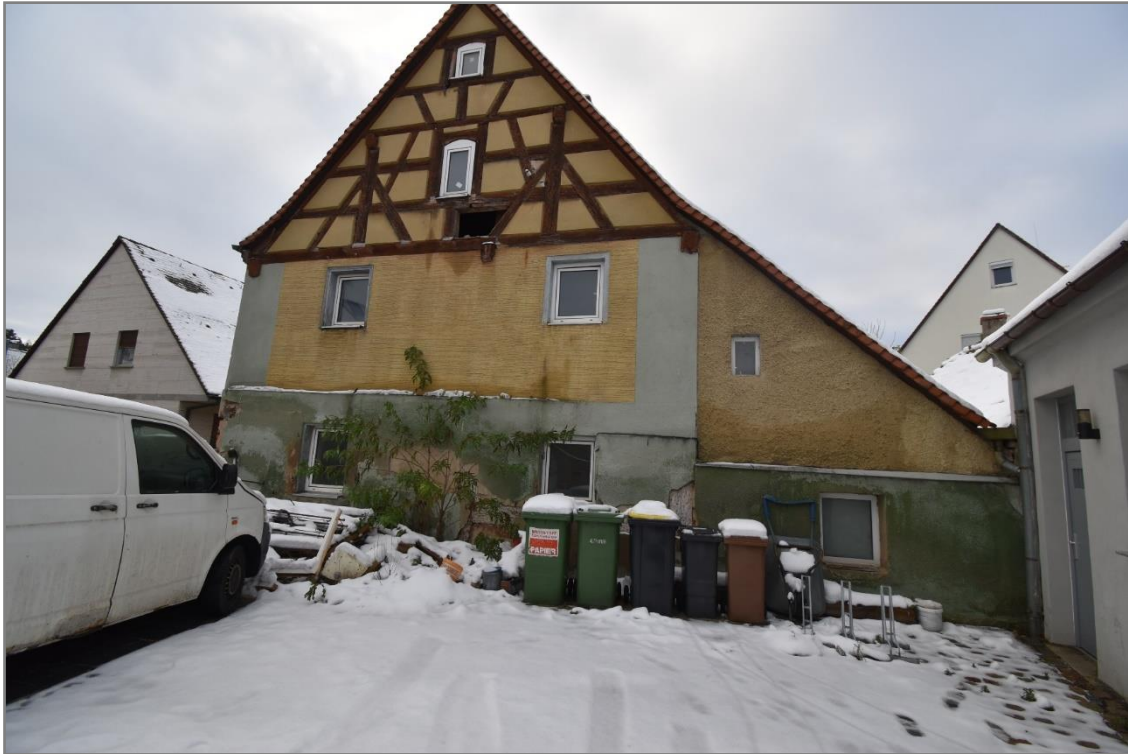
Blick vom Hof aus nach Westen auf das Wohnhaus mit Anbau nach Norden
