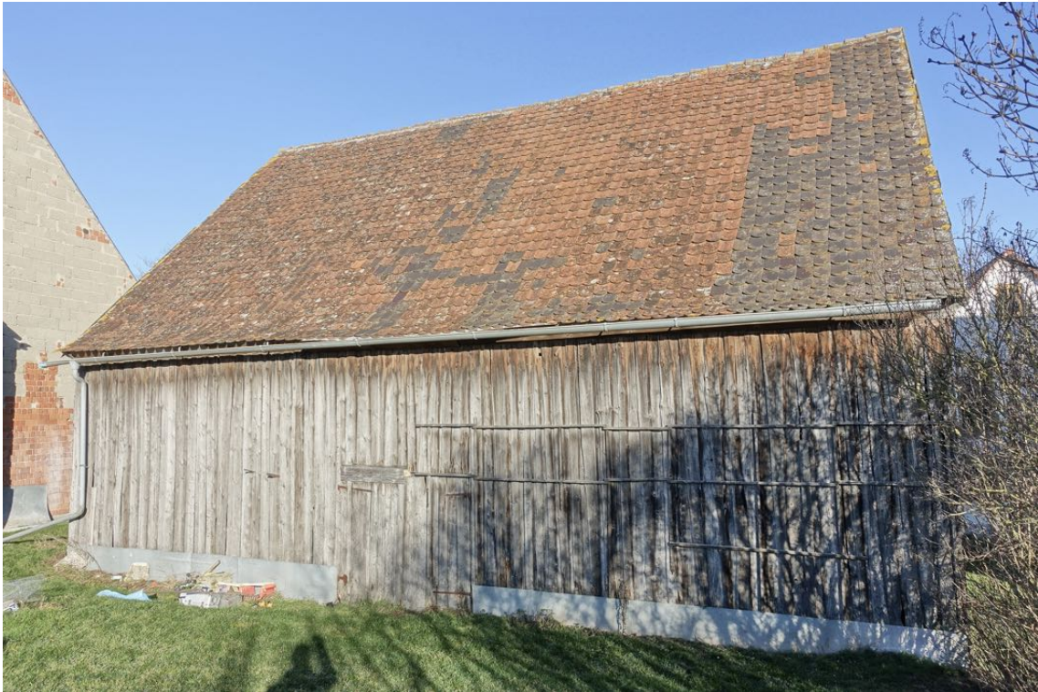
Scheune von Südosten
