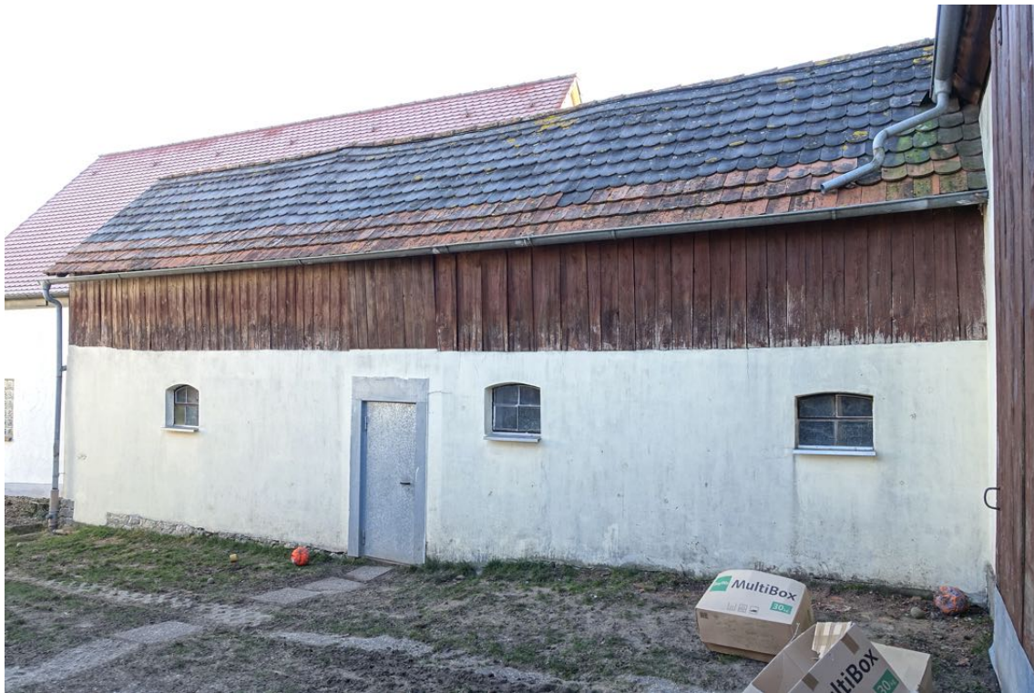
Nebengebäude, ehemaliger Stall
