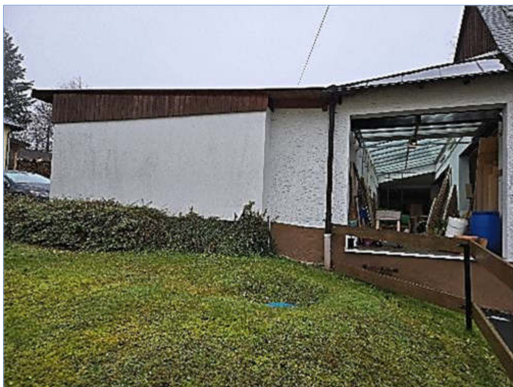
Bild 2 Pos. 01 Garagen, Südostseite
