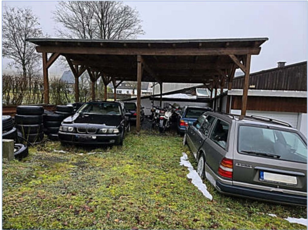
Bild 5 Pos. 01 Carport, Südwestseite
