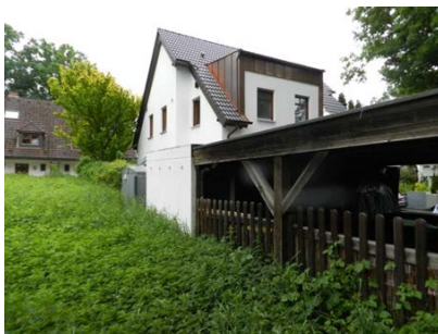
Fl.-Nr. 538/14, Blick von Nord nach Süd entlang der westlichen Grundstücksgrenze
