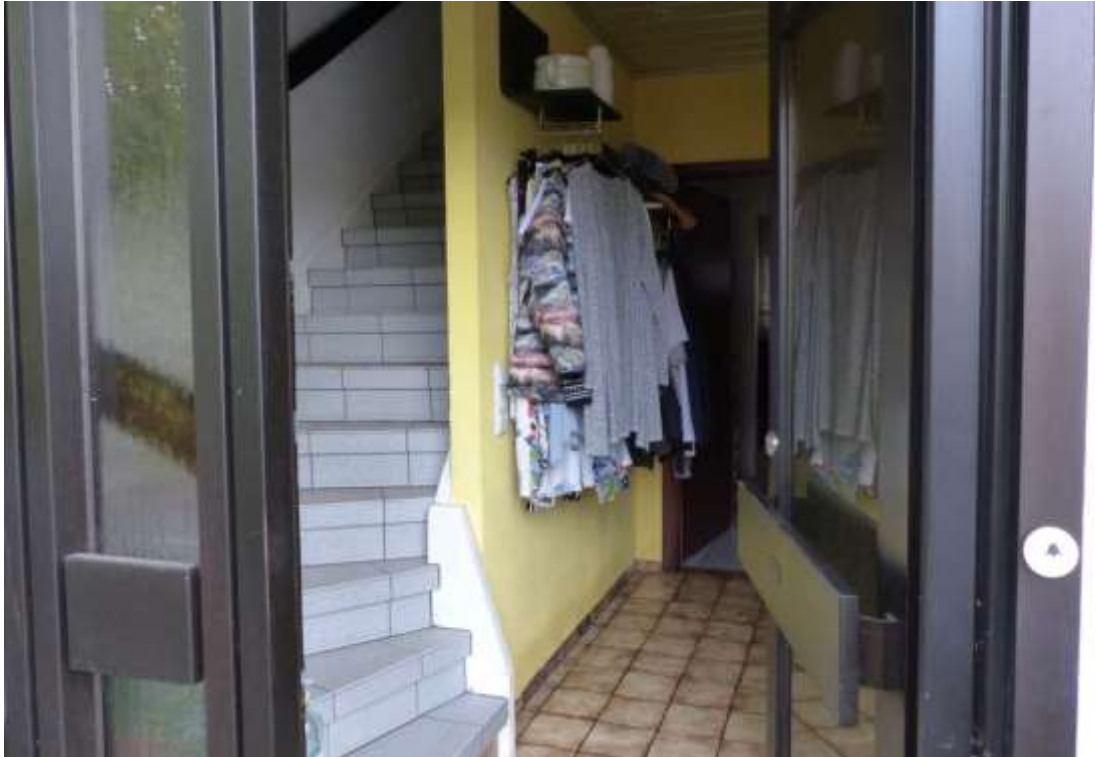
Abbildung 7: Blick in den Windfang mit Treppenführung zum Dachgeschoss
