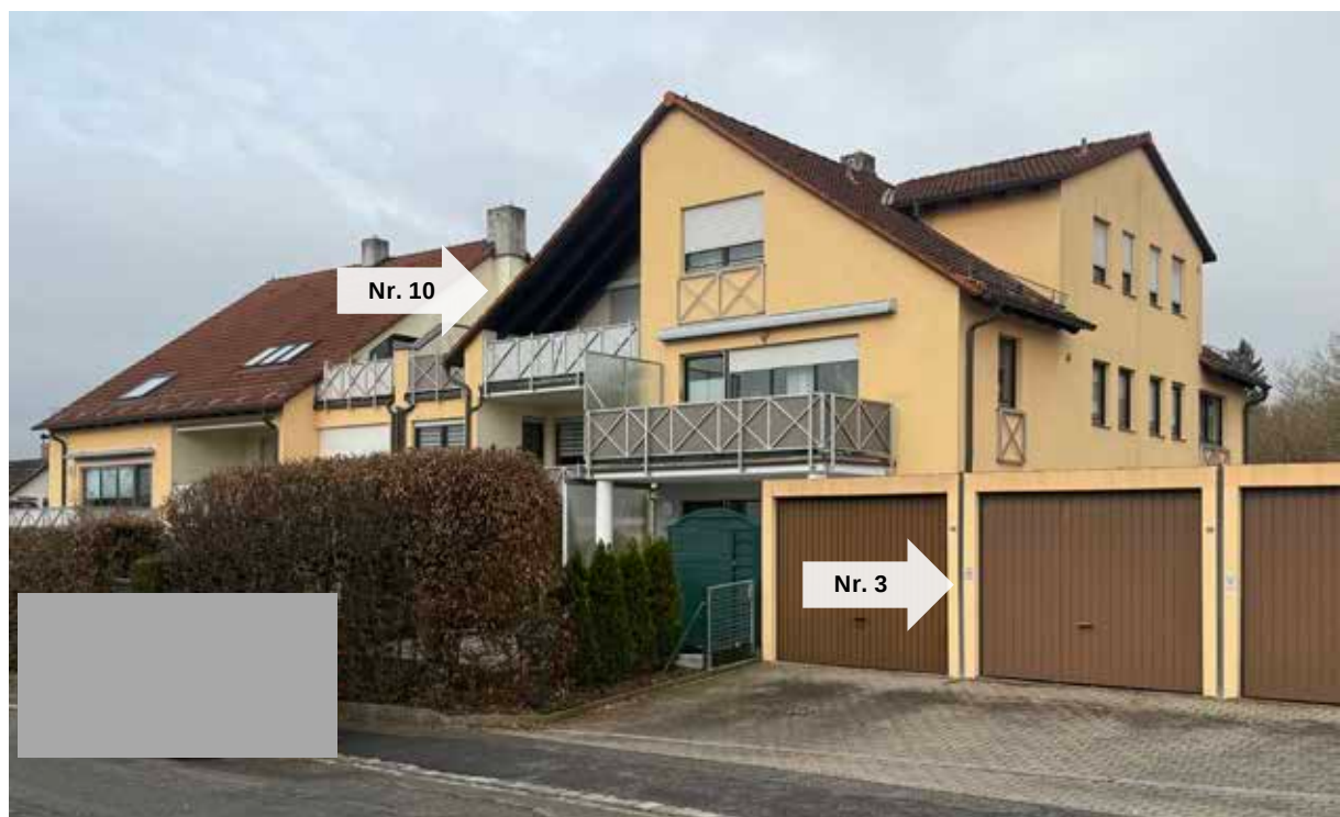
Abbildung 2 Ansicht von Osten
