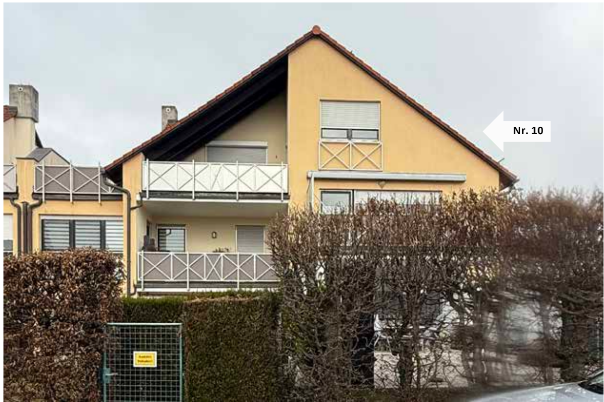
Abbildung 1 Ansicht von Südosten
