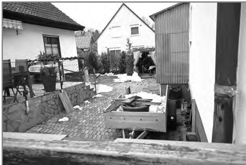
nordwestlicher Grundstücksbereich - Blick Richtung Nordosten
