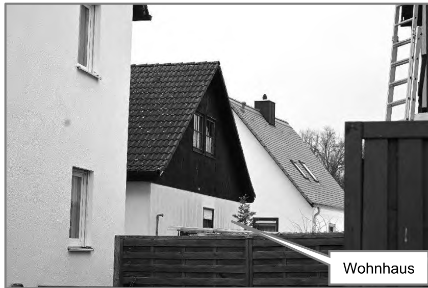
Teilansicht von Nordosten
