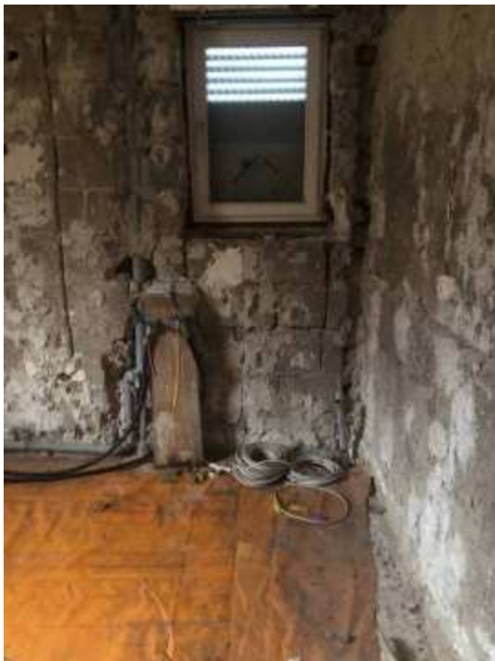
Umbaumaßnahme Erdgeschoss Haus 1
