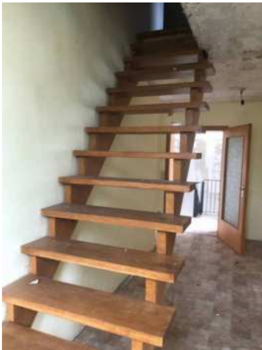
Treppe DG/Spitzboden Haus 1
