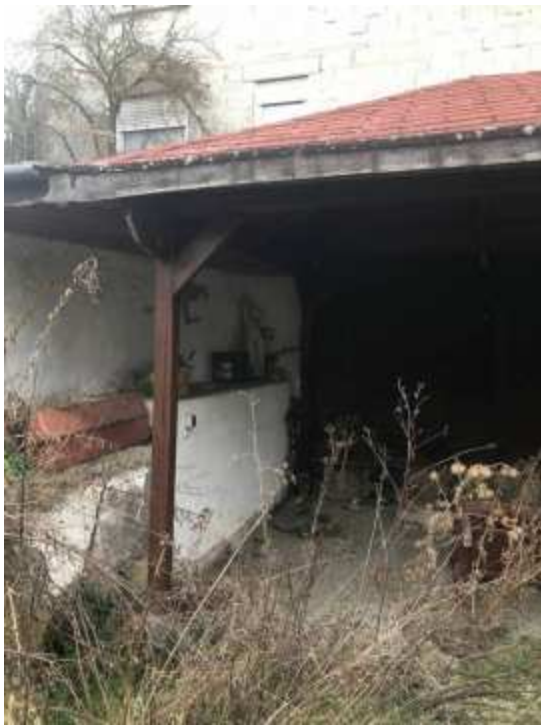
nördlicher Gartenbereich Überdachung
