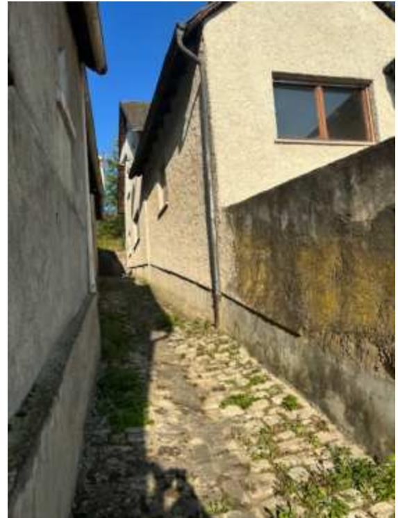
südlich angrenzender Fußweg
