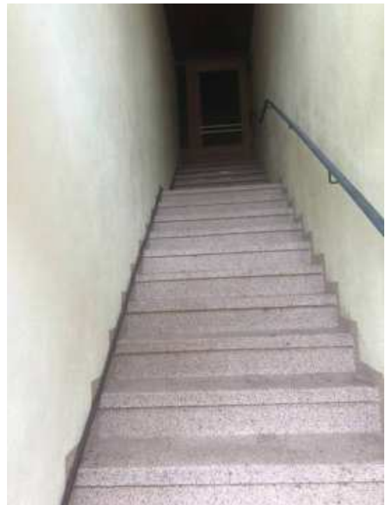
Treppe zum Erdgeschoss Haus 2
