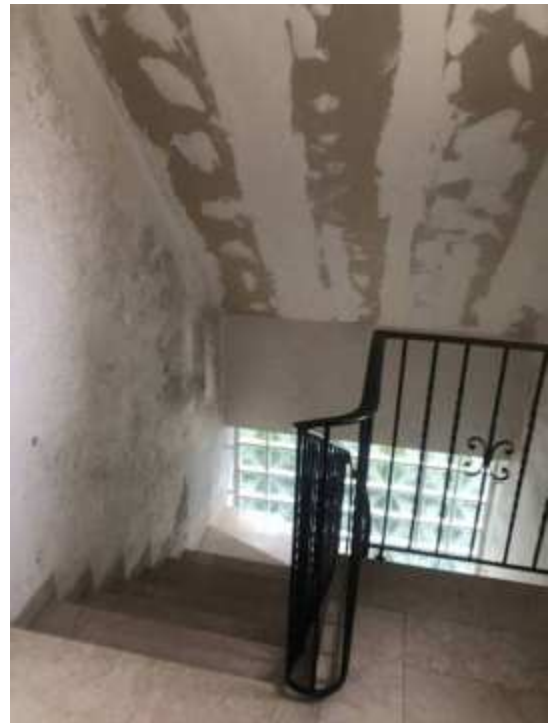
Treppenhaus Dachgeschoss Haus 1
