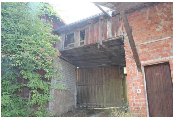
Durchfahrt zwischen Kuhstall und Scheune
