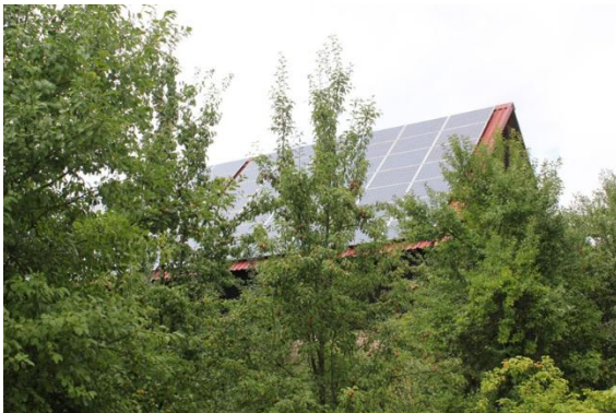
Süd-Ansicht Scheune mit PV-Anlage
