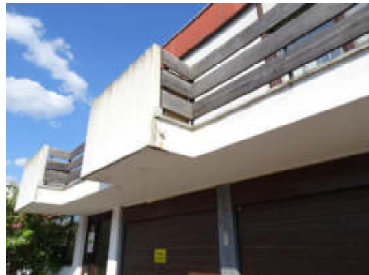
abgewitterter Balkon mit Schäden
