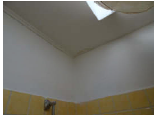
abgetrockneter Feuchteschaden mit Farbabplatzung
