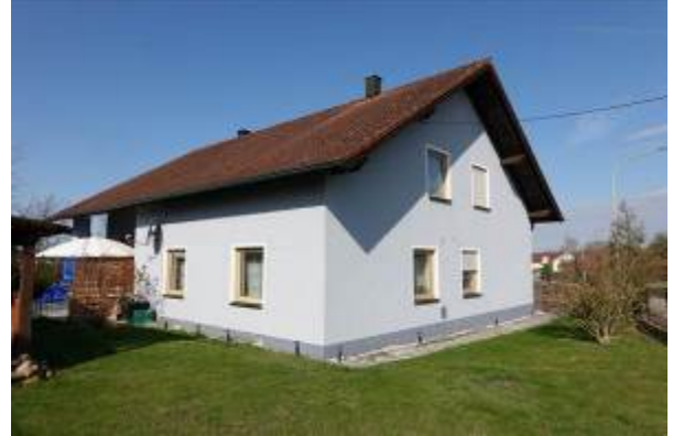
Einfamilienhaus, Blick aus südöstlicher Richtung
