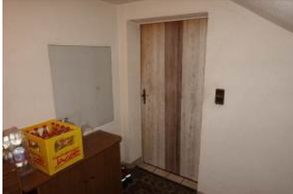
Eingang zum Kellergeschoss
