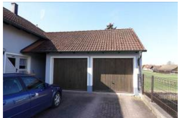
Doppelgarage, Blick aus nordöstlicher Richtung
