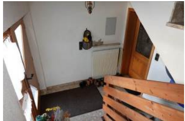
Treppe vom EG zum DG
