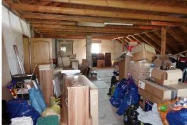
Nicht ausgebautes Dachgeschoss
