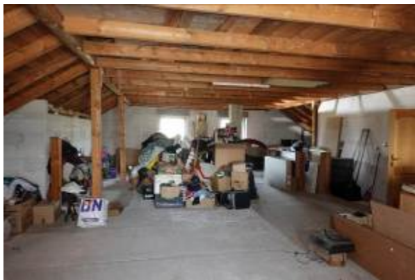
Nicht ausgebautes Dachgeschoss
