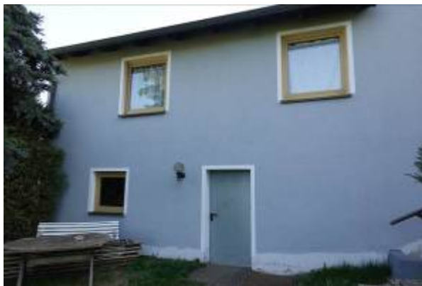
Doppelgarage, Blick aus südwestlicher Richtung
