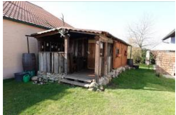
Gartenhaus, Blick aus nordöstlicher Richtung
