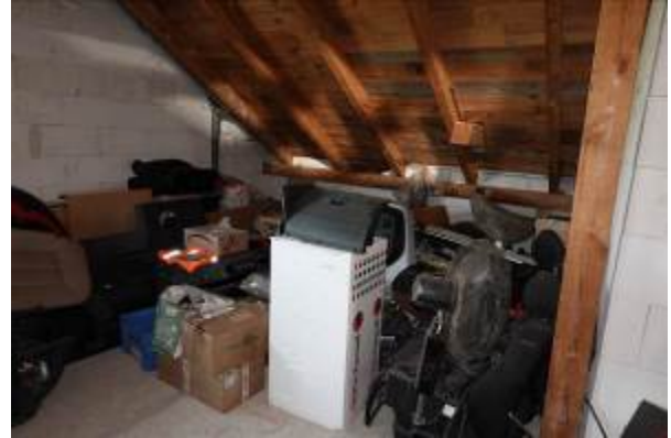
Nicht ausgebautes Dachgeschoss
