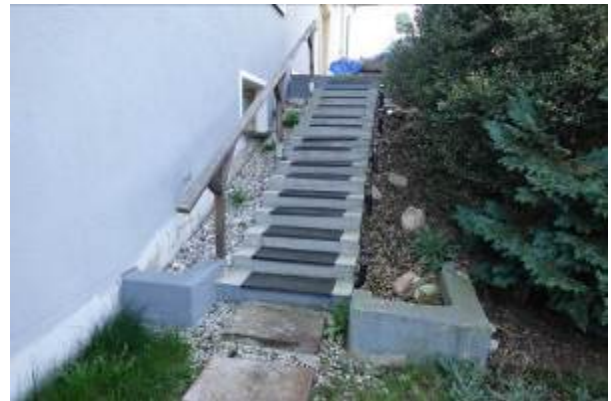
Außentreppe zur Südwestterrasse
