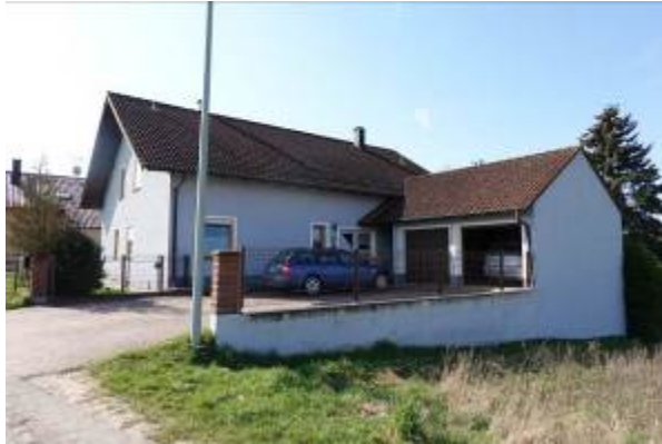
Bewertungsobjekt, Blick aus nördlicher Richtung
