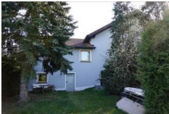
Einfamilienhaus, Blick aus westlicher Richtung
