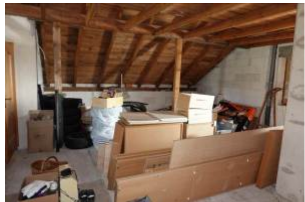
Nicht ausgebautes Dachgeschoss
