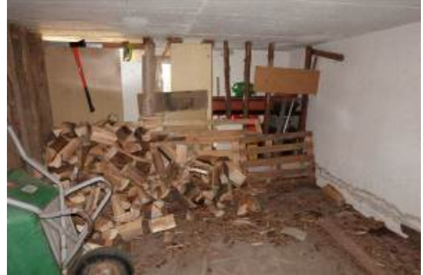
Abstellraum unter der Doppelgarage (KG)
