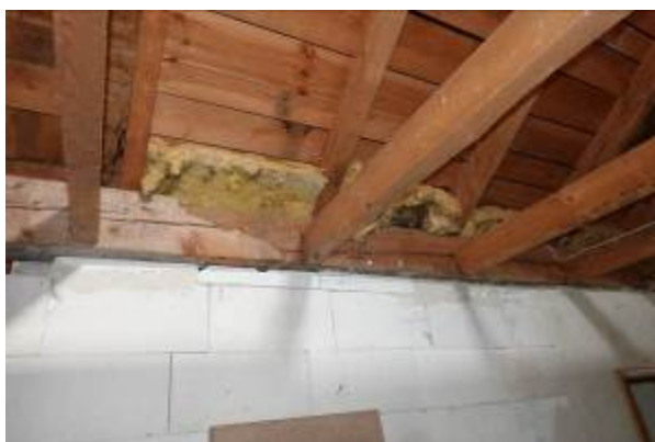
Mangelhafte Wärmedämmung
