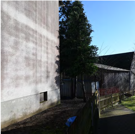
Aufsteigende Feuchtigkeit, korrodiertes Kellerfenster
