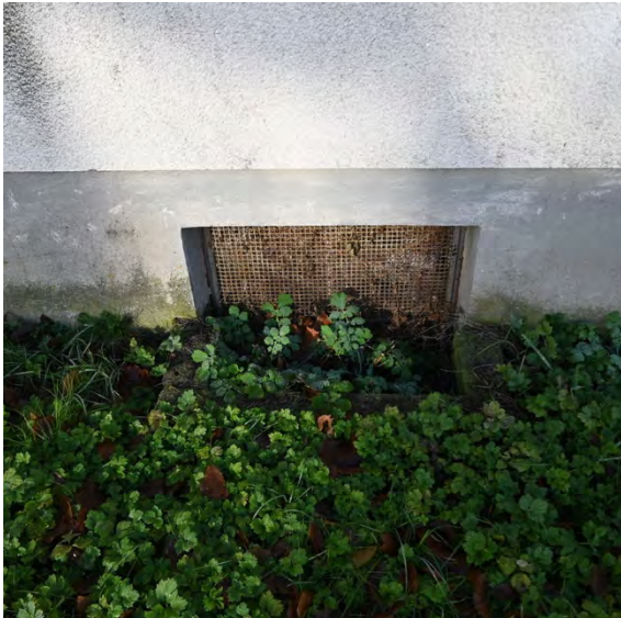
Aufsteigende Feuchtigkeit, korrodiertes Kellerfenster
