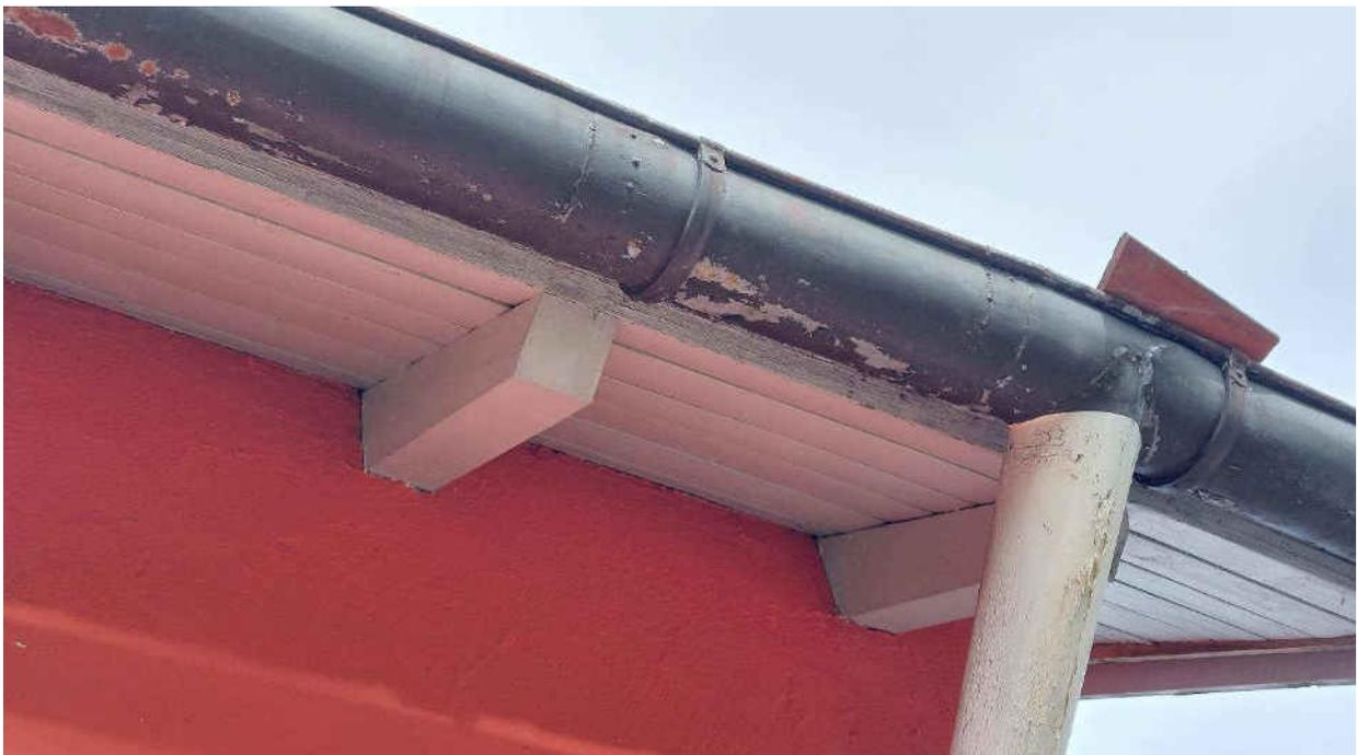
Foto 20 – Verwitterungsspuren im Bereich der Spenglerarbeiten
