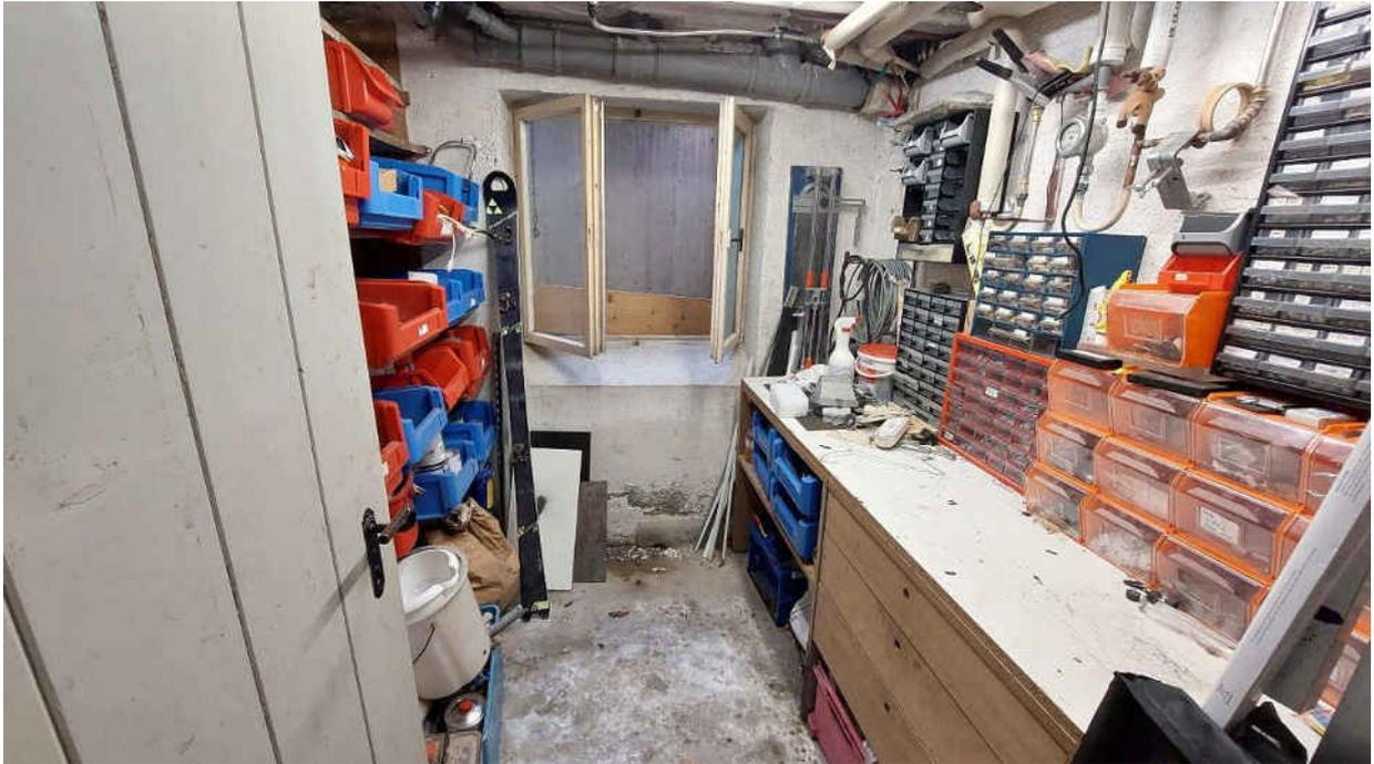
Foto 17 – Werkstatt im KG, mit Farbabplatzungen und Ausblühungen am Außenwandsockel
