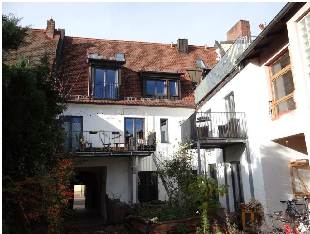
Bild 3: Ost-Ansicht des Hauptgebäudes
