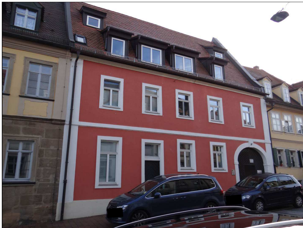
Bild 1: Blick auf das Anwesen Mittlerer Kaulberg 37 von Nord-Westen
