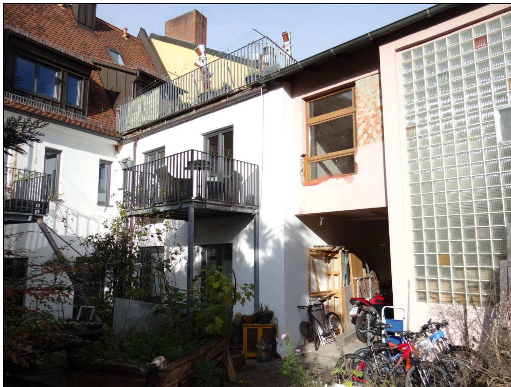
Bild 4: Süd-Ost-Ansicht des Anbaus
