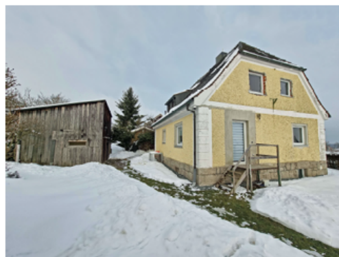
Schuppen Ost- ... Wohnhaus ... Südseite Ansicht von Südwesten (vom Garten)
