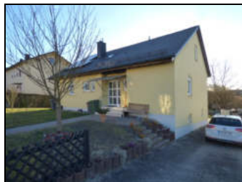
Ansicht von Nordosten (Straßenseite)
