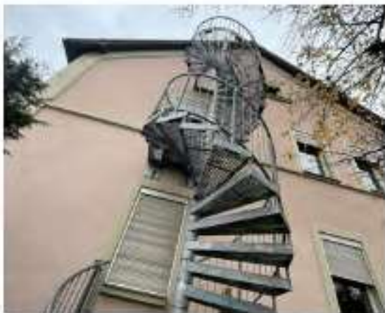
Außentreppe an der WH-Fassade N
