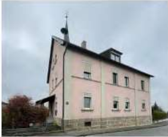
Blick aus Richtung SO auf das Dreifamilienwohnhaus
