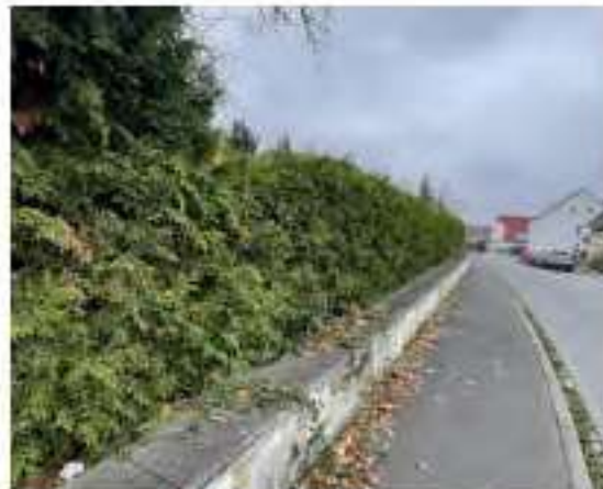
Einfriedung nördlicher Grundstücksbereich
