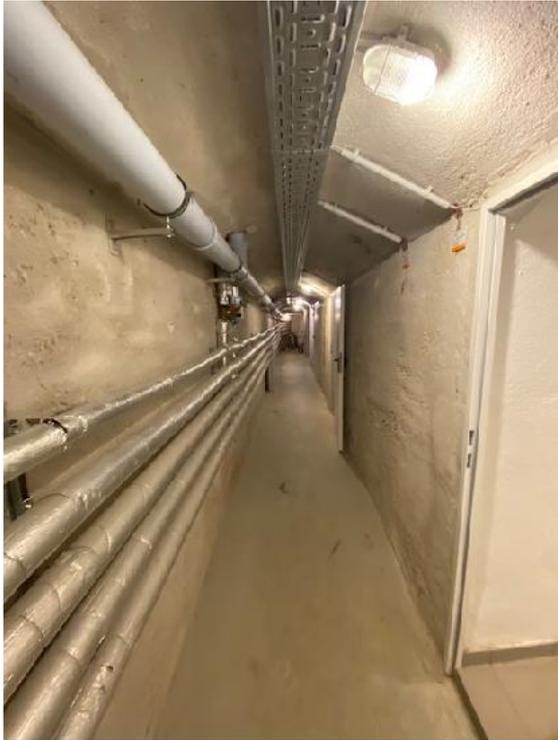
Bei dem zu bewertenden Kellerraum Nr. 4 im hinteren Bereich des Gebäudes handelt es sich um eine Gewölbekonstruktion, Decke und Wände sind verputzt und gestrichen. Am Fußboden ist ein Fliesenbelag verlegt.
