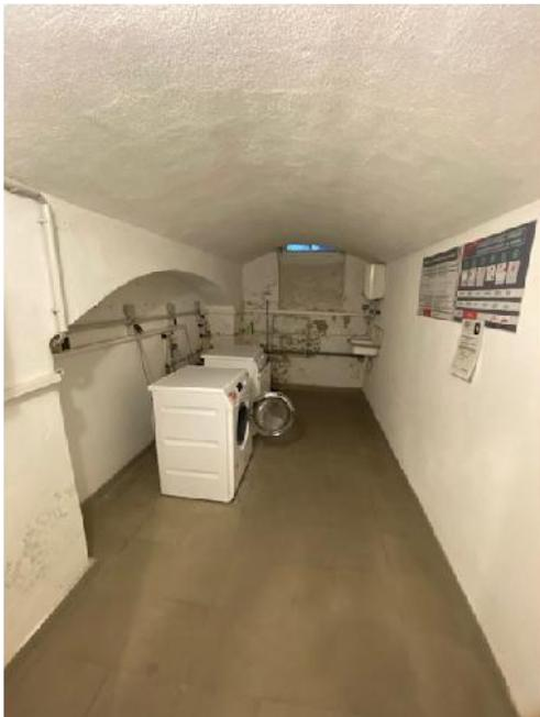
An der Außenwand gibt es Farb- und Putzabplatzungen aufgrund von Feuchtigkeit.
