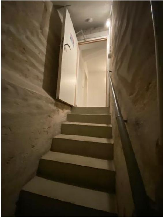
Der Keller ist relativ trocken, er kann als Lager genutzt werden. Die Decken sind Gewölbekonstruktionen, die Wände sind verputzt, jedoch nicht gestrichen. Am Fußboden ist ein Zementestrich verlegt, dieser ist beschichtet.
