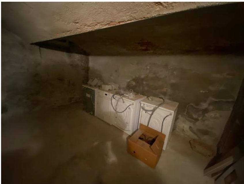
In dem Kellerraum gibt es 2 Tonnengewölbe, Decken und Wände sind verputzt und am Fußboden ist ein Estrich verlegt. Im Bereich der Wände, aber auch im Bereich der Decke gibt es Putzfehlstellen, die Wände sind aufgrund von Feuchtigkeit
