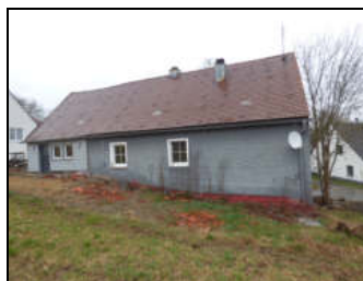
Aktuelle Ansicht von Südosten
