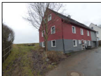
Aktuelle Ansicht von Nordosten (Gebäudezugang)
