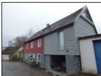
Aktuelle Ansicht von Nordwesten (Gebäudezugang, Garagenteil)
