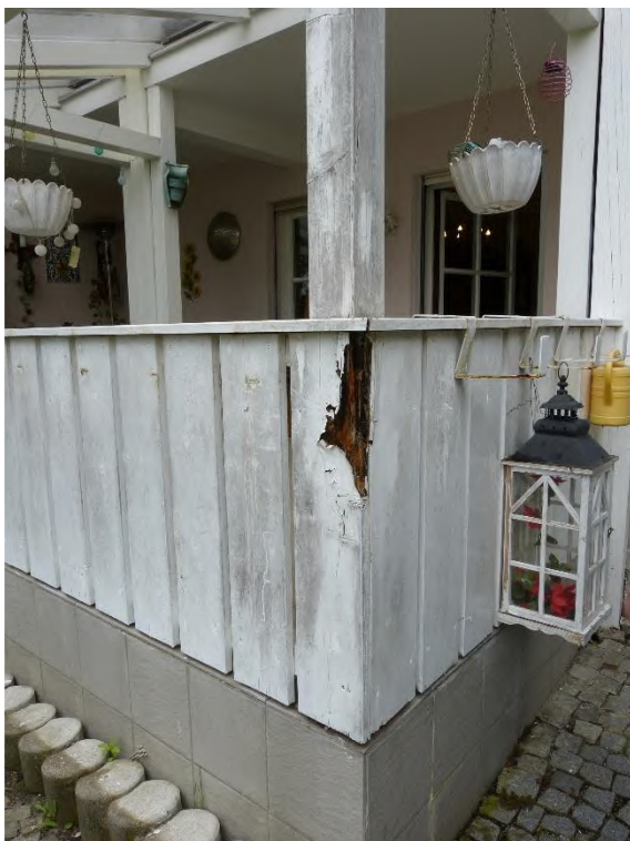
Gebäude 1: Einfamilienhaus mit Praxisräumen, Teilansicht schadhaftes Terrassengeländer
