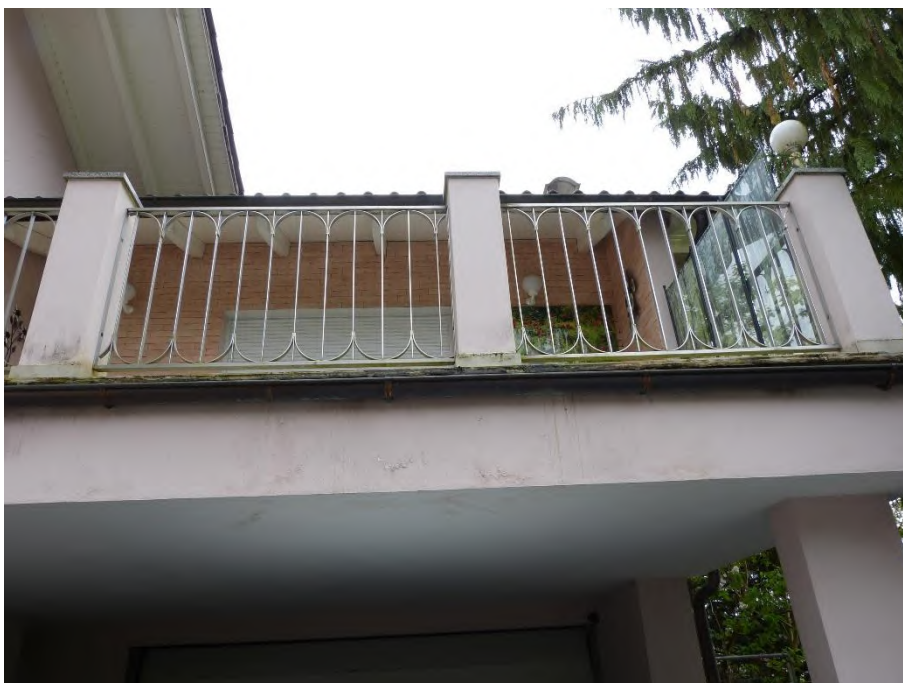
Gebäude 2: Garagenanbau, Teilansicht Terrasse über Garagenanbau mit Schaden an Attika
