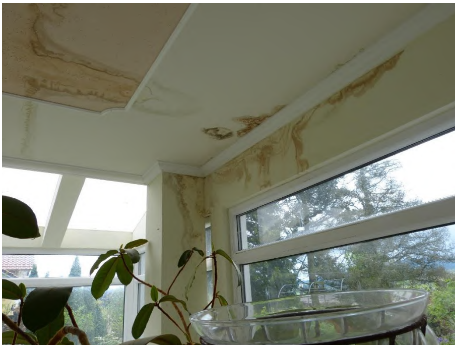
Gebäude 1: Einfamilienhaus mit Praxisräumen, Innenaufnahme Wintergarten mit Wasserschaden
