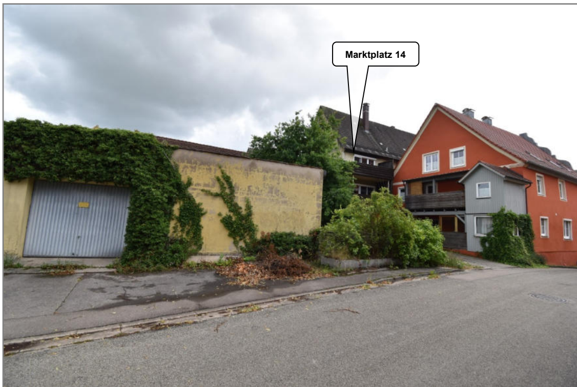
Blick von der Straße Reitbahn aus nach Südosten, links vorne das Garagengebäude, mittig hinten das Wohnhaus
