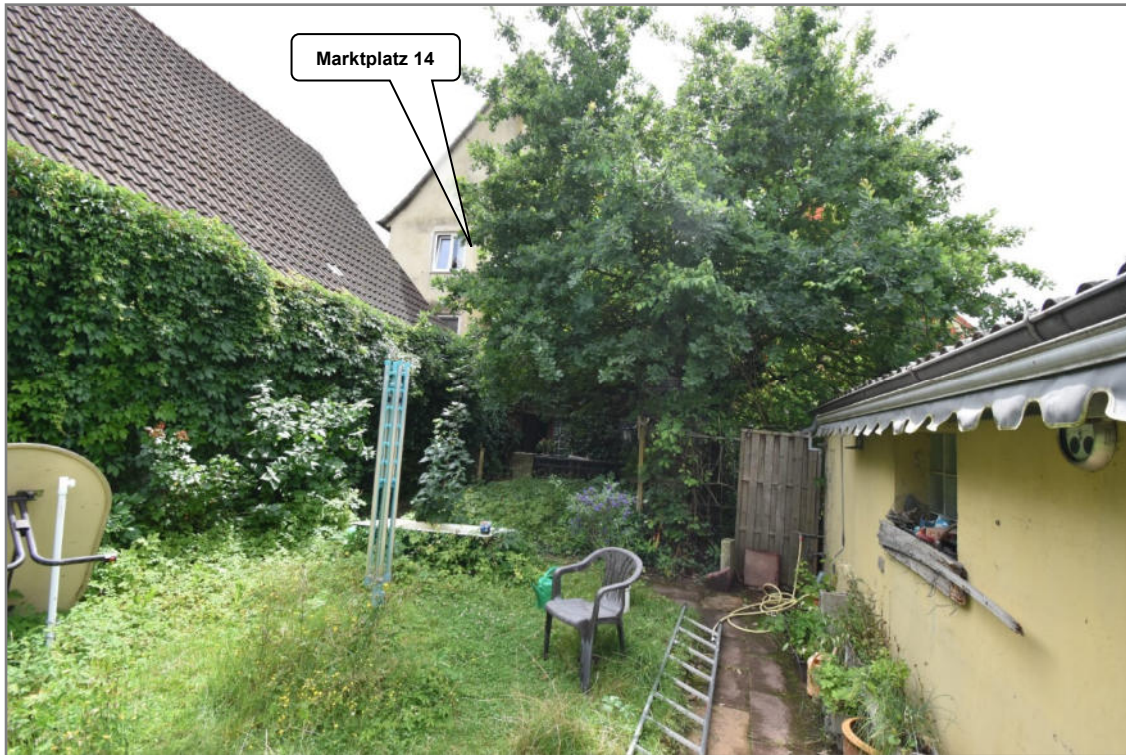
Nähe Reitbahn, Gartengrundstück, Blick vom Garagengebäude aus nach Süden in den Garten, hinten das Wohnhaus
