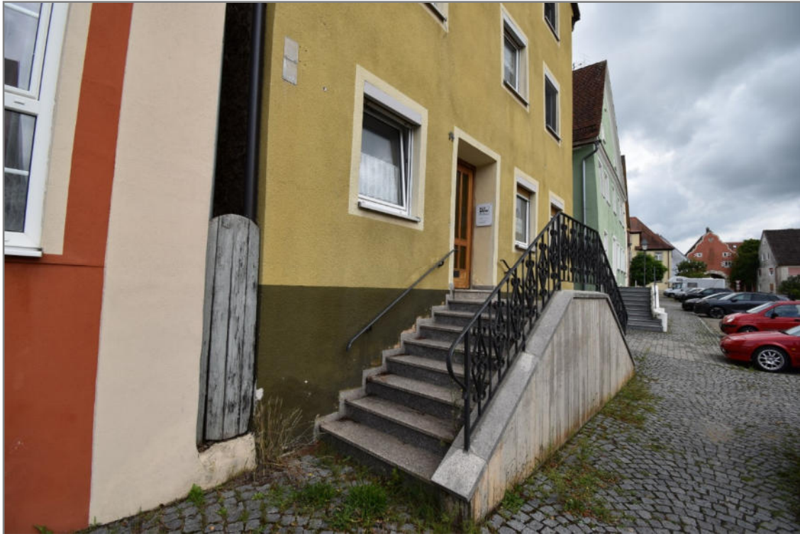
Marktplatz 14, Blick auf den Eingangsbereich mit Außentreppeanlage an der südlichen Giebelseite des Wohnhauses
