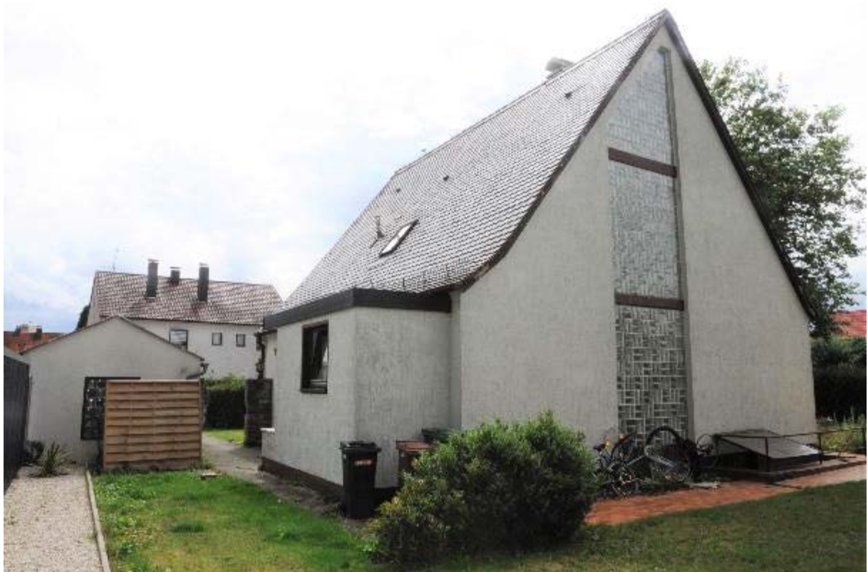
Abbildung 2 Ansicht von Nordosten
