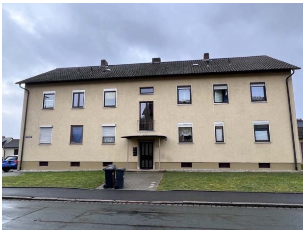
Ansicht aus nordöstlicher Richtung
