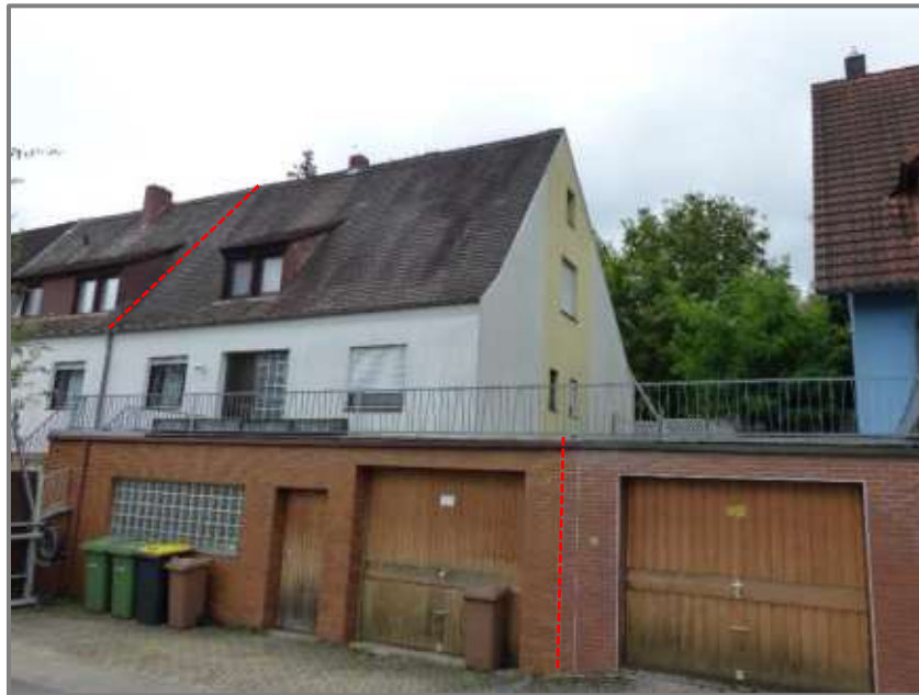
Objekt 1 (Hsnr. 28a) - Ansicht von Nordwesten
