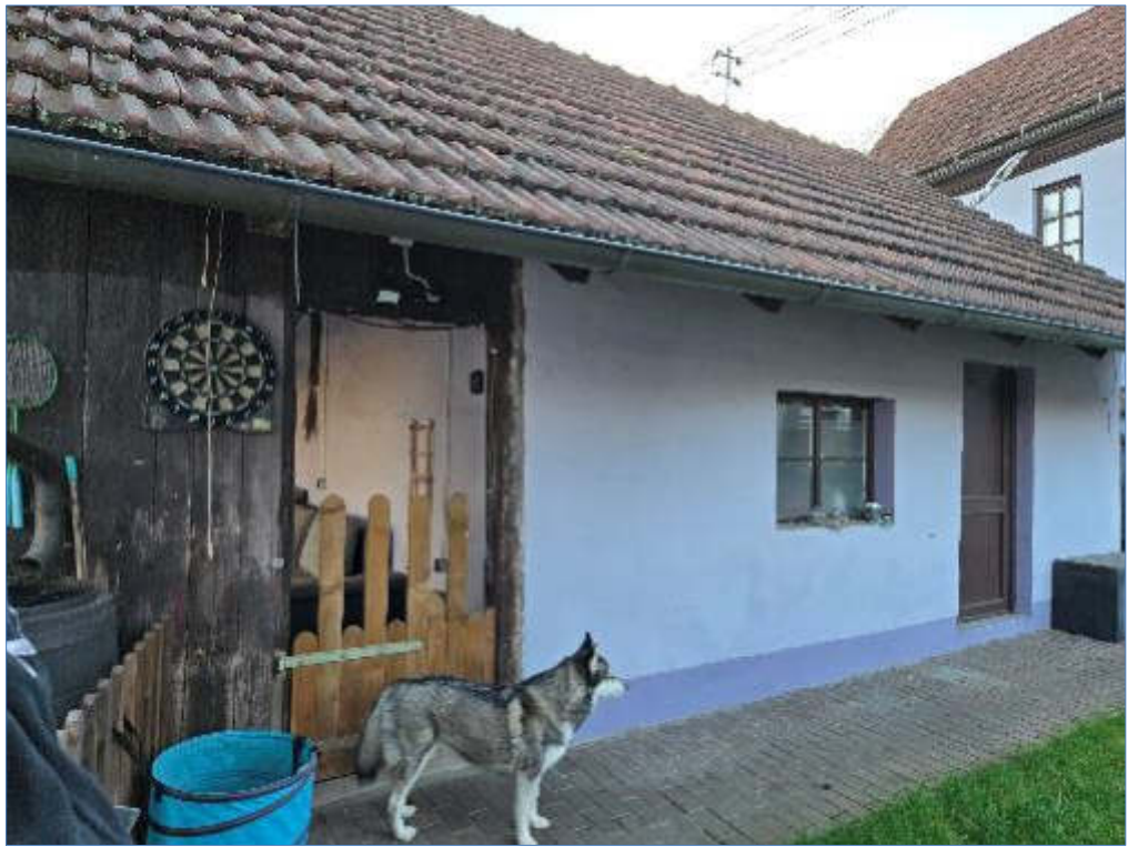
Bild 10 BBT Nebengebäude, Nordseite
