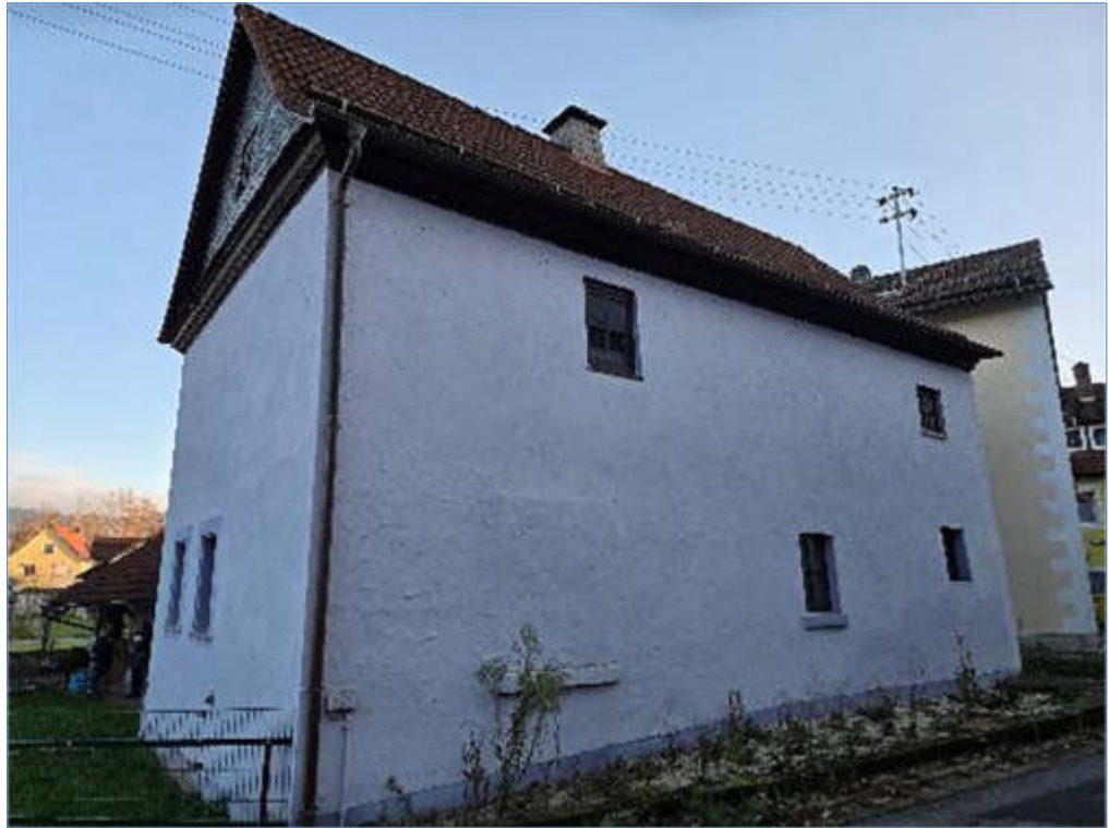
Bild 3 Pos. 01 Wohnhaus, Westseite
