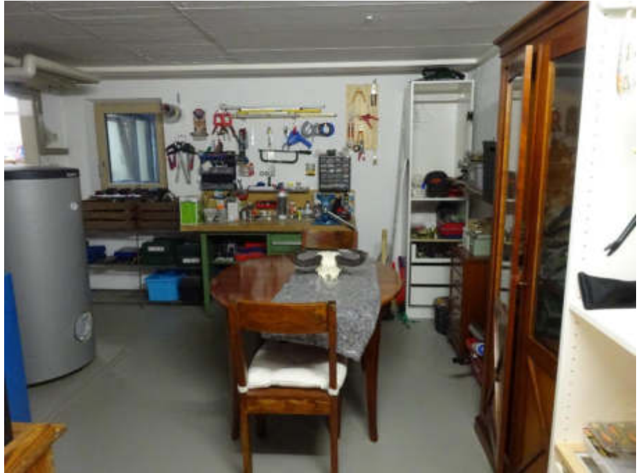
Wasch- und Heizkeller
