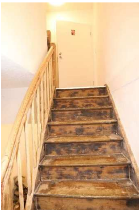
Treppe vom 2. Obergeschoss zum Dachgeschoss
