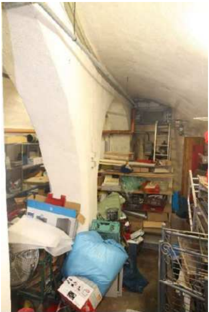
Kellergeschoss - Kellerraum 1 im Altbauteil
