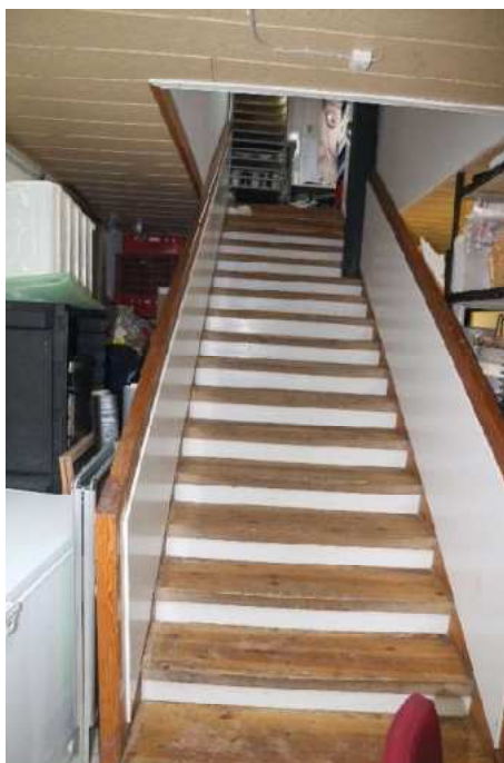
Treppe vom Keller- zum Erdgeschoss
