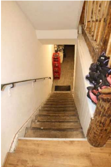
Treppe zum 1. Obergeschoss
