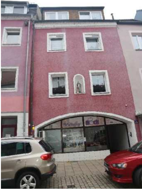
Ansicht von Nordosten
