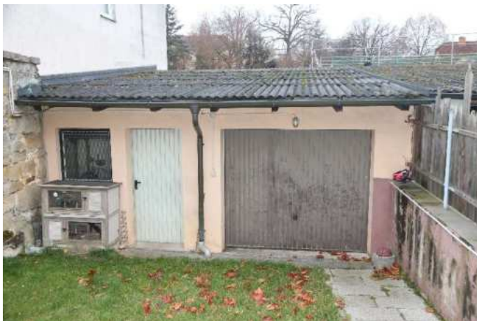
Garage – Ansicht von Nordosten
