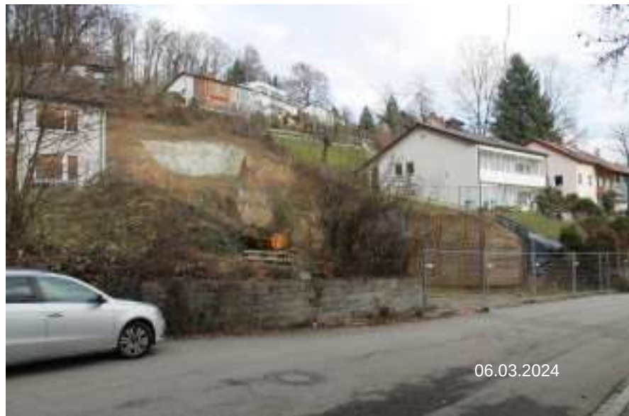
Bild 2: Ansicht Grundstück von Südwesten von Godehardstrasse
