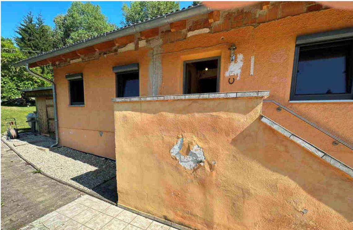
Detailaufnahme: Putzabplatzungen an der Zugangsseite
