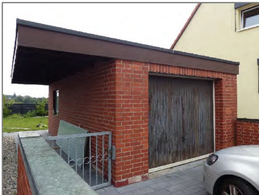
Garage (südlich) - Ansicht von Westen
