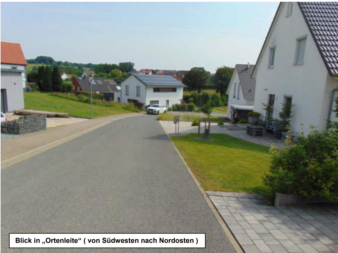
2) Garage: Südostseite bzw. Südwestseite ( von S )
