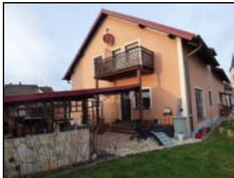
Ansicht von Südosten (Straßenseite)
