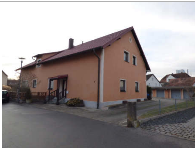
Gesamtansicht von Osten mit Grundstückszufahrt
