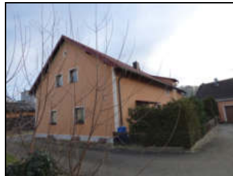
Ansicht von Norden (mit Grundstückszufahrt)
