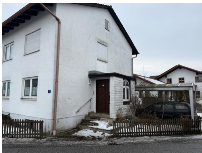
Nordansicht mit Zugangsbereich
