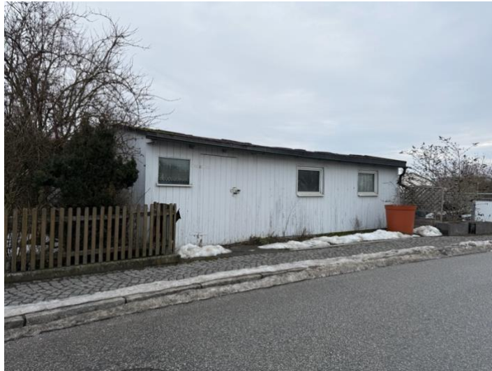
Südansicht Nebengebäude auf Grundstück Flurnummer 99/3
