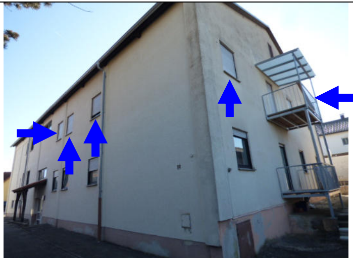
Ansicht Gebäude Galgenweg 6 von Nordwesten mit Markierung ETW.-Nr. 5 im Gebäude
