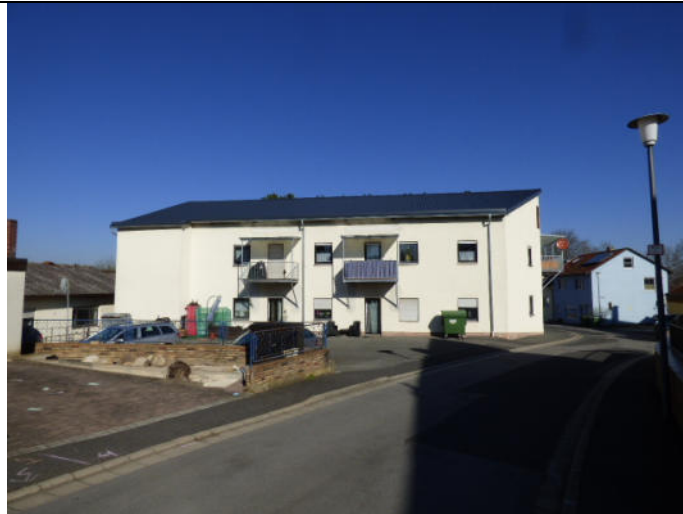
Außenansicht von Südosten mit befestigten Zufahrtsbereich 2
