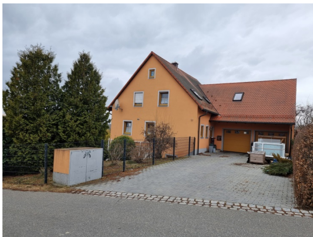
Wohnteil Garagenteil Ansicht von der Straße (von Osten)
