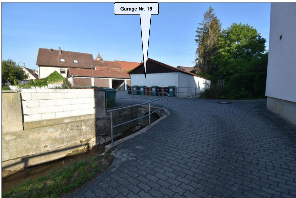
Zufahrt über den Lanzenbach zum Garagengrundstück FINr. 278/17
