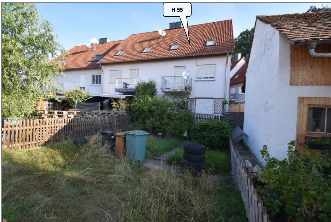
Blick von der Ortsdurchgangsstraße aus nach Norden auf das Wohngrundstück
