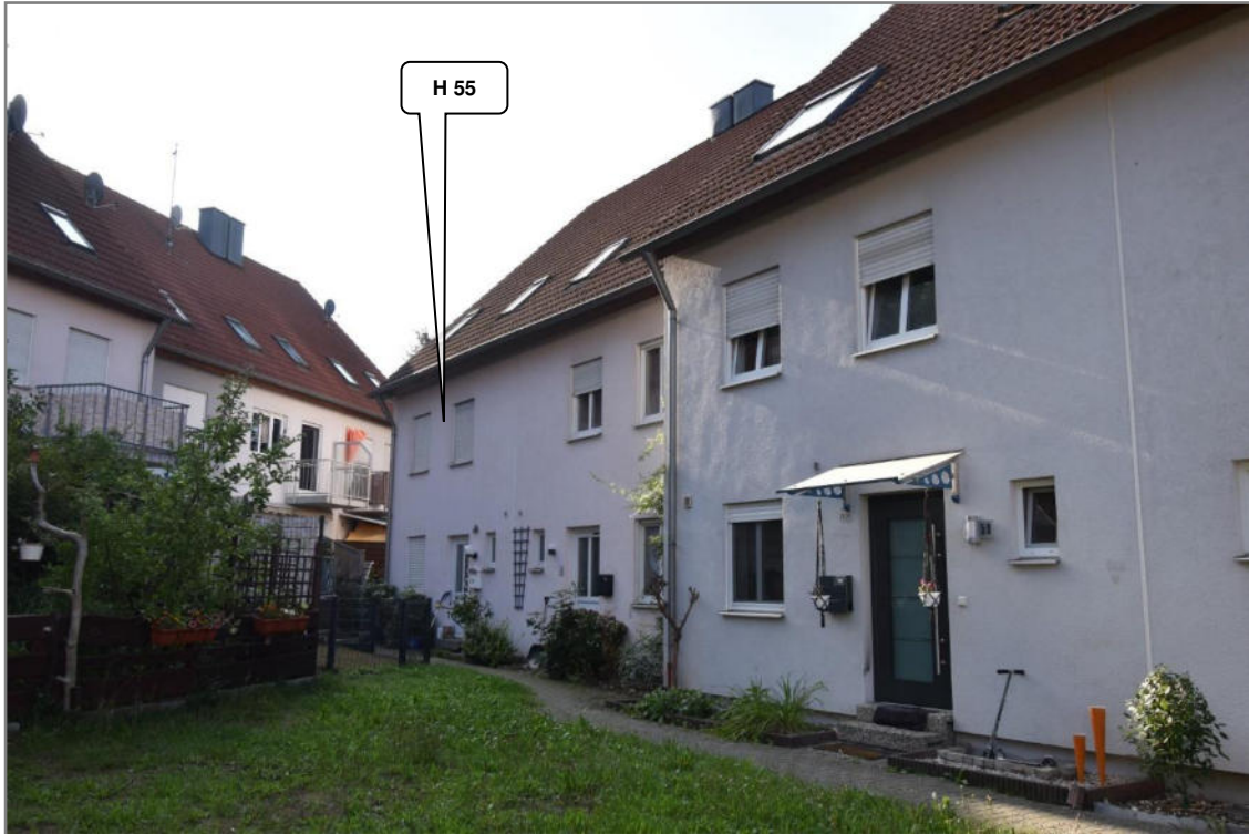
Blick vom Zufahrts-/Wegegrundstück, FINr.278, aus nach Südosten auf das Wohngrundstück
